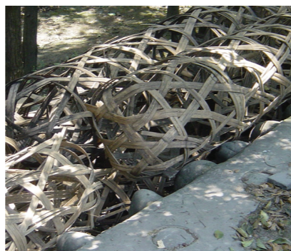
图 5.2 竹篾子在鱼嘴堰被用来减缓水流的速度
