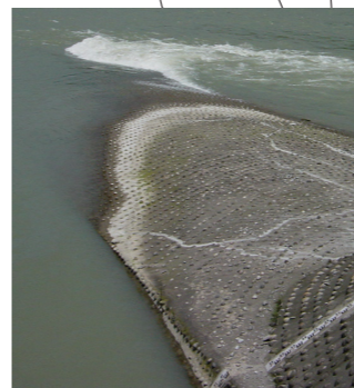
图 5.3 鱼嘴堰，将水流分隔成快速与慢速的水流
