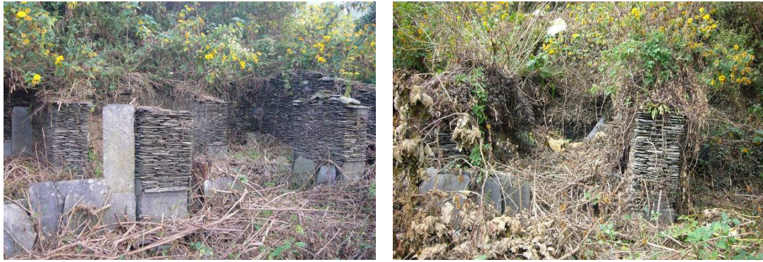
C 開間與牆體長度仍完整可辨識，僅牆體高度部分毀壞者 D 家屋開間已不清晰，僅餘部分牆體者。
